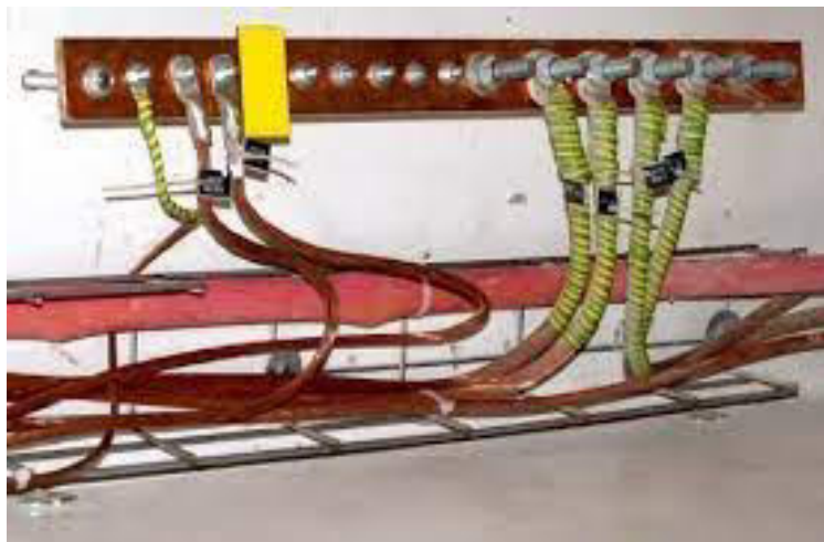
Рисунок 7.9—Приклад загальної потужної енергетичної шини з однаковим потенціалом
