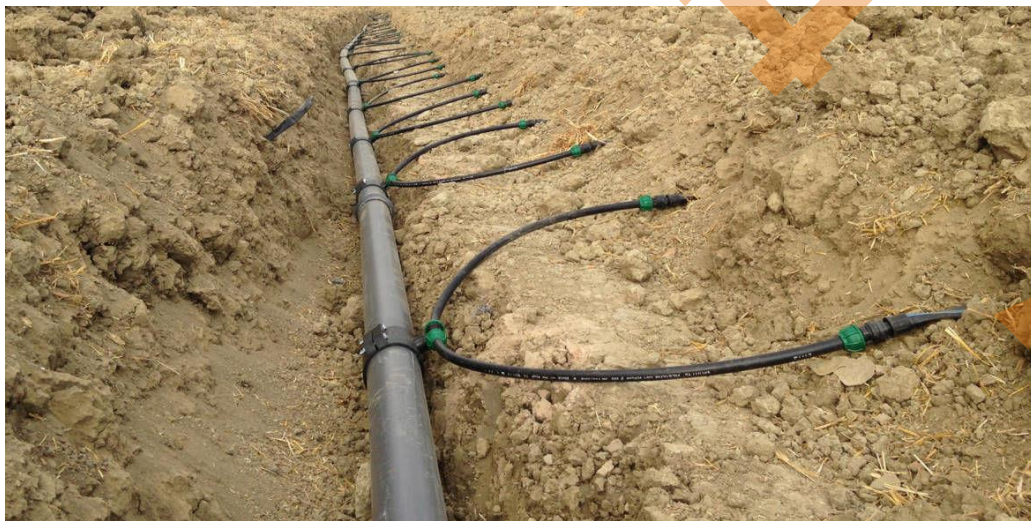
Рисунок 2.3 – Підгрунтова система поливу [3]
