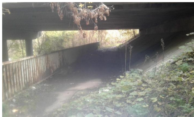
Рис.1.10. Опора Боздоського моста
