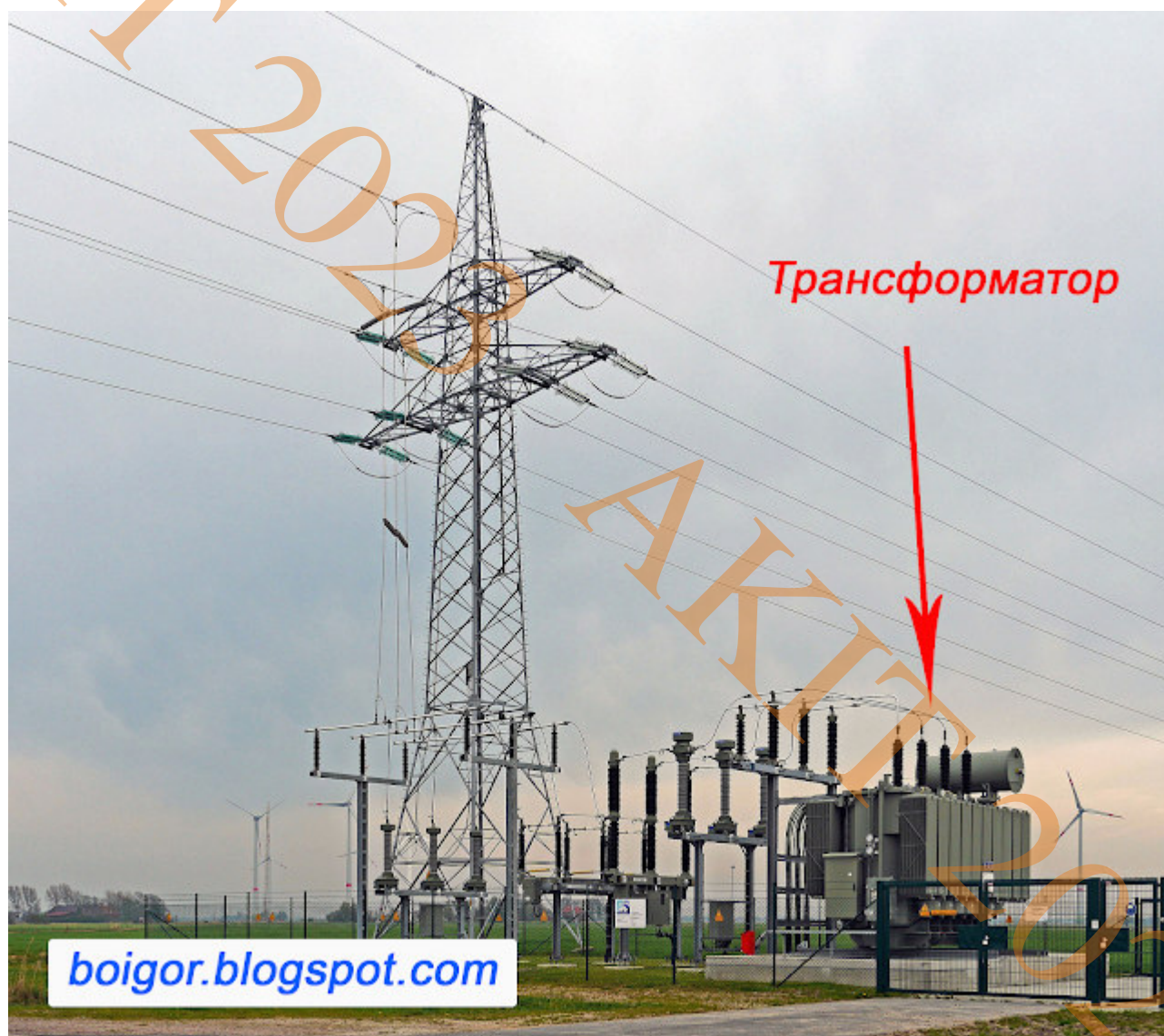
Рис. 2.2 Зовнішній вигляд силового трансформатора розподільчої мережі
