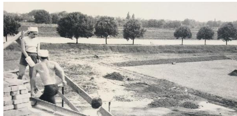
Будівництво гуртожитку на набережній
